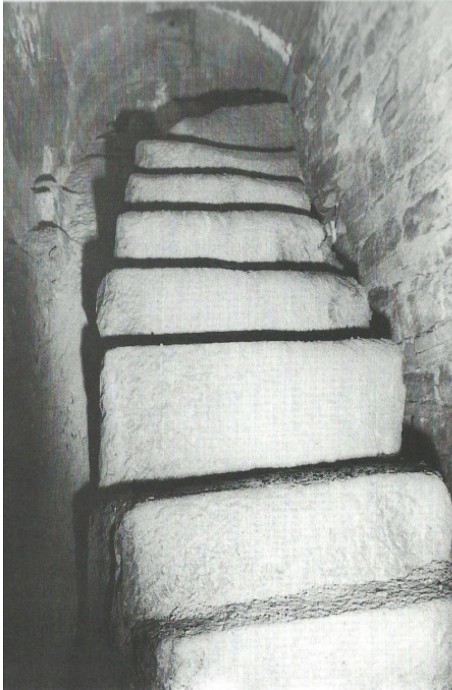
Scala romana situata al'interno dello stabilimento dei "Bovi" alle terme alte.
