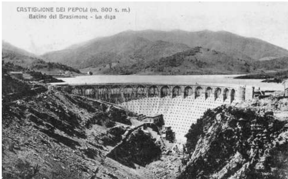
La diga del Brasimone in corso di ultimazione.
