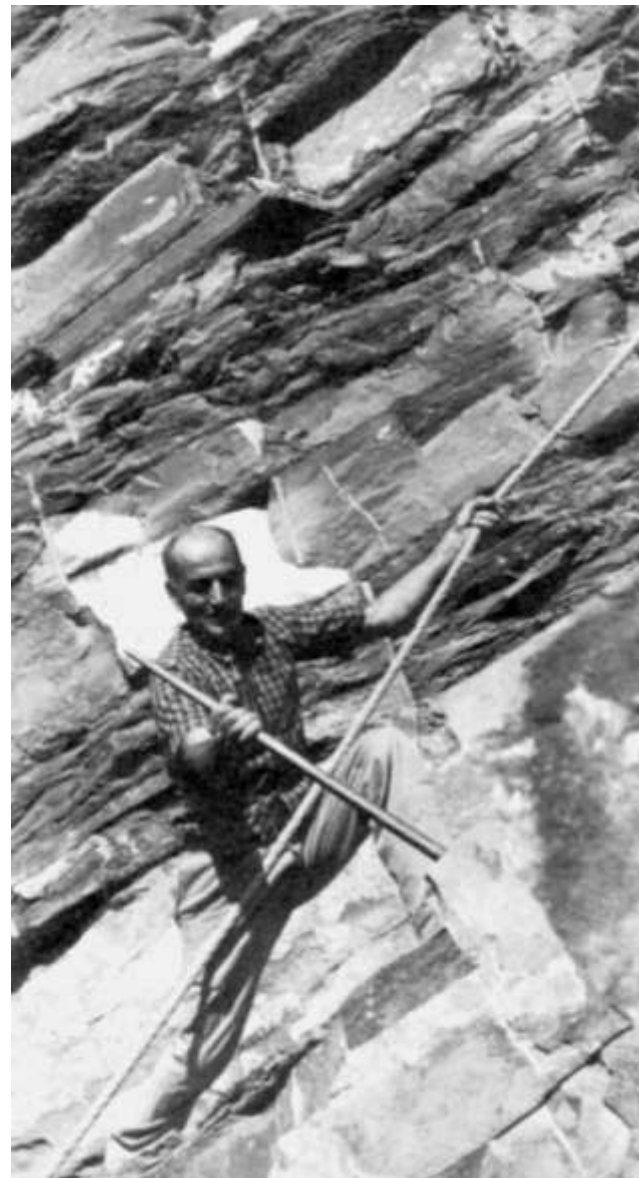
Operazione di sgaggio nella cava della Porchia presso Pianaccio di Lizzano in Belvedere (archivio Carisbo).
