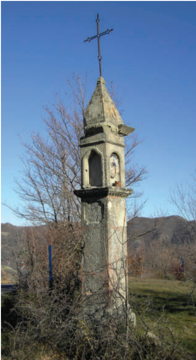
Il pilastro di Razola prima e dopo la pulitura con idropulitrice e interventi di rifacimento e stuccatura con malta da ripristino (foto Enrico Carboni).
