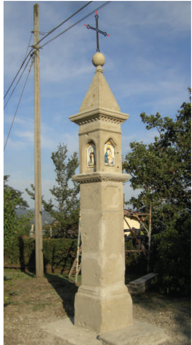
Il pilastro di Razola prima e dopo la pulitura con idropulitrice e interventi di rifacimento e stuccatura con malta da ripristino (foto Enrico Carboni).
