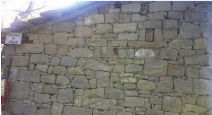
Muro posato a secco in edificio rurale.
