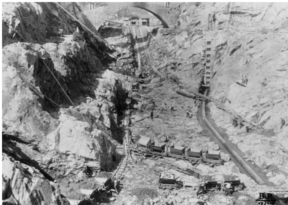
Il cantiere della diga di Suviana.
