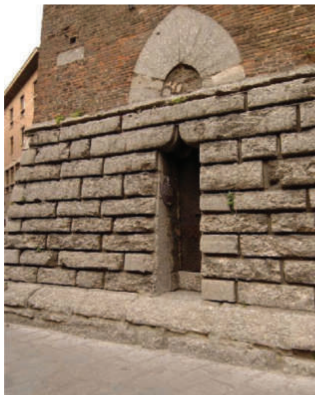
Base in selenite della torre Garisenda a Bologna.
