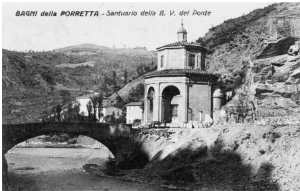
Tempietto della Madonna del Ponte e deposito di lastre e conci di pietra ricavati dall'attigua cava (pr. Alfonso Ferri).
