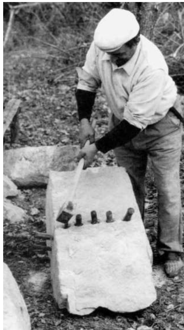
Taglio di tronco o di mozzatura. Le foto sono state scattate da Aniceto Antilopi durante il corso di scalpellini a Campolo nel 1989.
