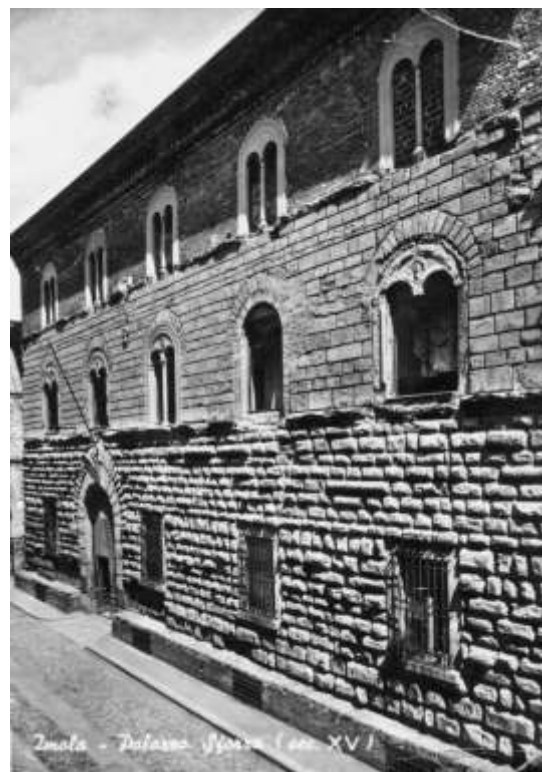
Rifacimento con pietra di Montovolo delle bifore del palazzo Sforza di Imola (pr. Maurizio Nicoletti).
