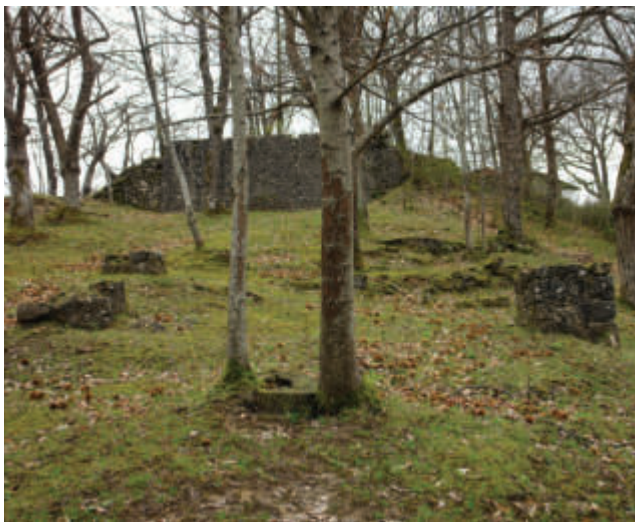
I resti della stazione di partenza della filovia fotografati nel 2015.
