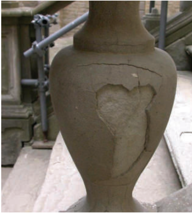
Esempio di degrado della pietra serena per formazione di croste (foto da info@restauriamo.eu).
