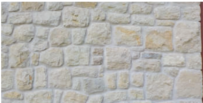
Muratura a "filaretto".
