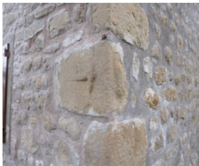
La Valle di Tavernola (Grizzana M.). Pietra angolare con la martellina e croce greca incisa.
