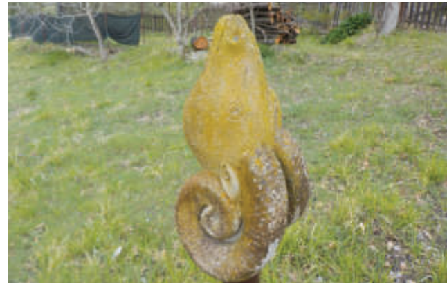
Alterazione cromatica dovuta all'azione di microrganismi vegetali.
