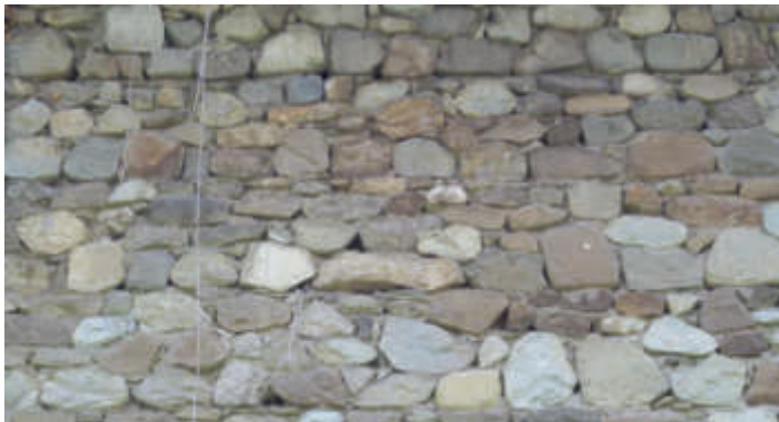
Muratura di "fabbrica" con sassi di fiume.
