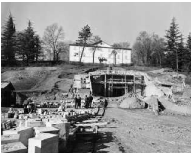
Il cantiere del mausoleo di Guglielmo Marconi con conci quadrati del Montovolo pronti per essere montati (pr. Maurizio Nicoletti).
